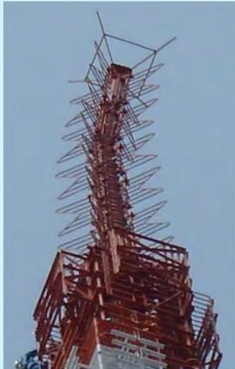
Torre de Tokio Antena doblada por sismo
