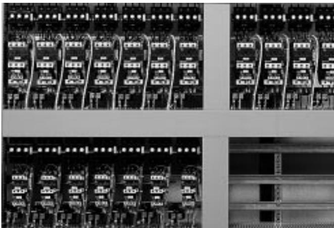
Arrancadores con contactores LC1-D y relés térmicos LR2-D
