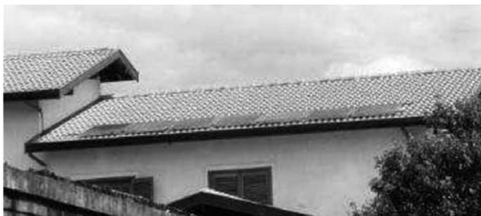
Figura 6.16 – Instalación de mini colectores en larga batería (Fuentes: acervo Soletrol)
