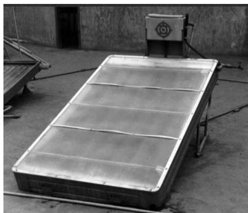
Figura 6.1 – SCAES del tipo integrado, el pequeño tanque en su cabecera mantiene el nivel y lo conecta con el suministro de la red.
