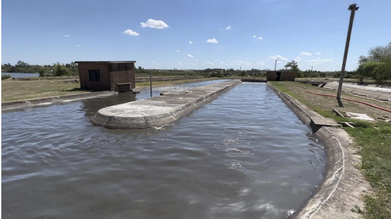
Figura 1.- Foto de una de las zanjas de oxidación en operación (Set 2023).
