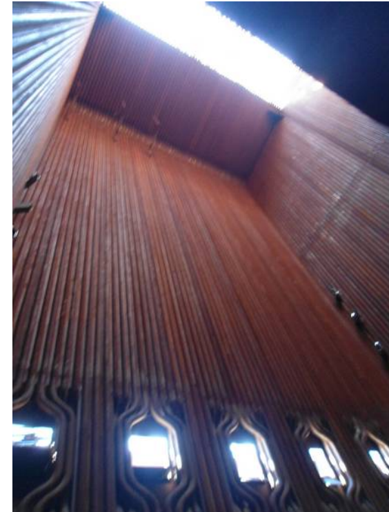
Fornalha de caldeira em construção
