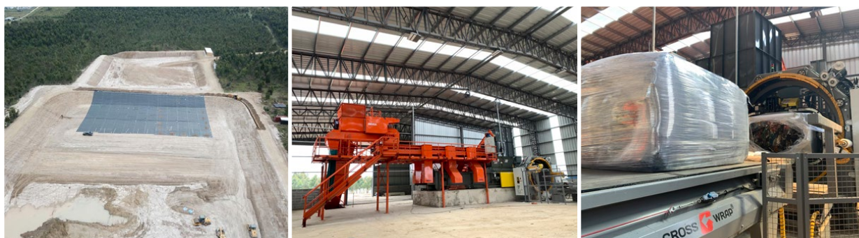
Ilustración 2: Relleno sanitario Rocha, durante la etapa de construcción
