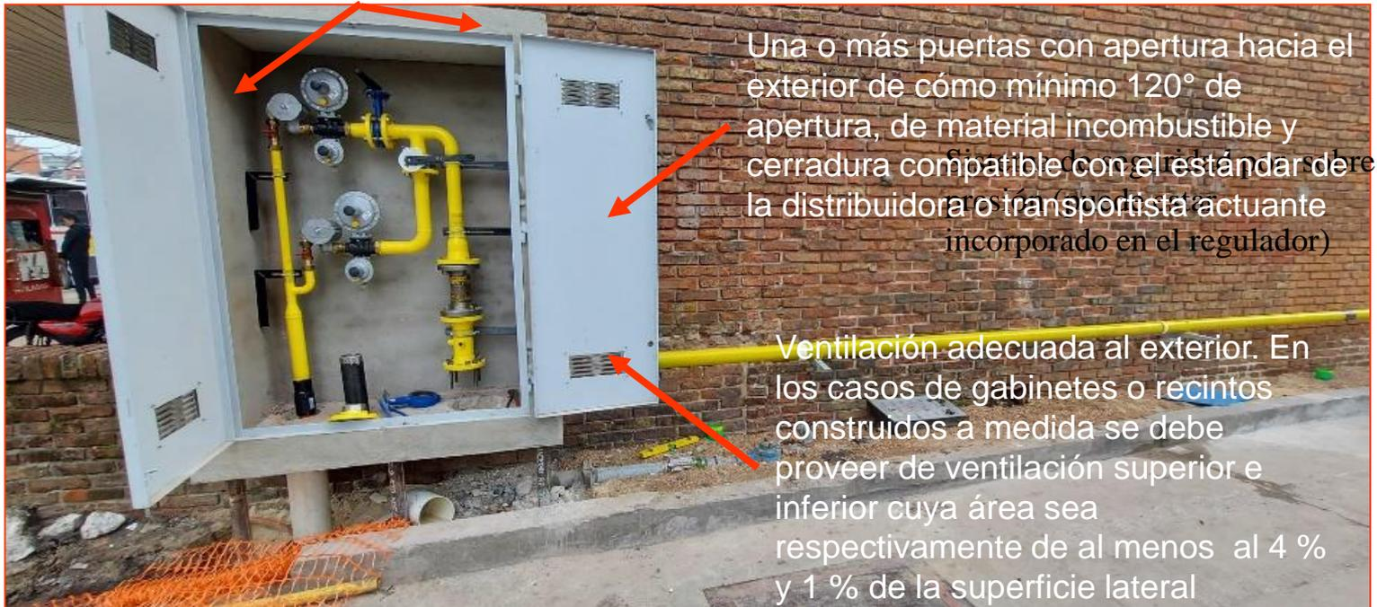
En caso de instalación eléctrica deben ser apta para clase 1, división 2, según la clasificación dada por la norma NFPA 70 o para zona 2, según la clasificación dada por la directiva ATEX
