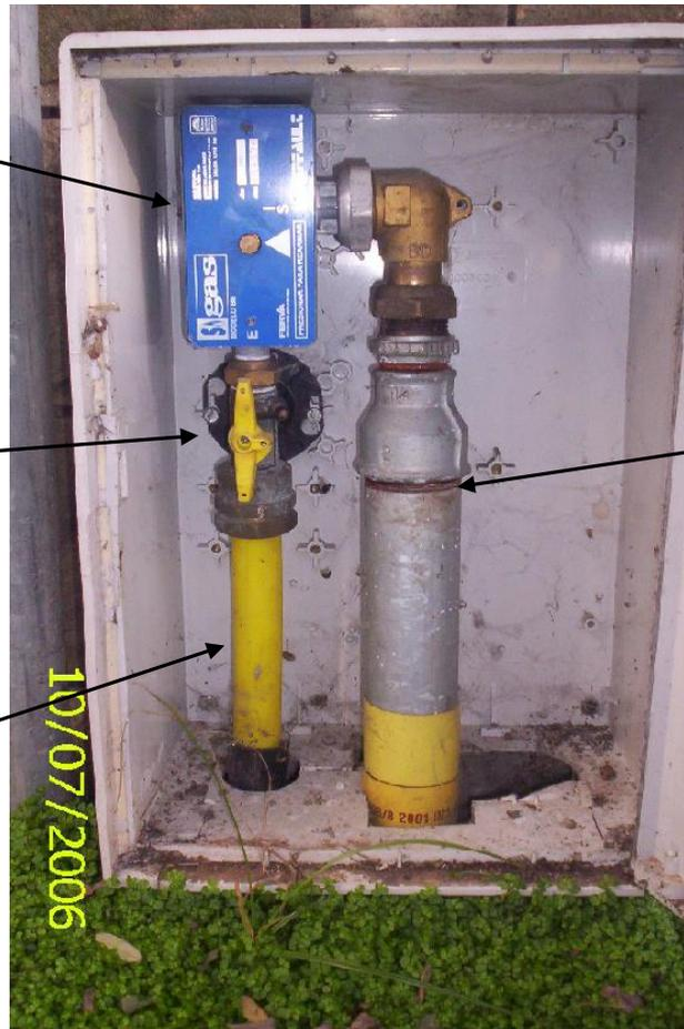
Acometida en baja 20 mbar en H.G. protegido con cinta tipo poliguard
