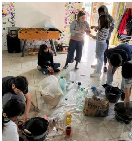
Imagen 2: Primera jornada de construcción con hormigón.
