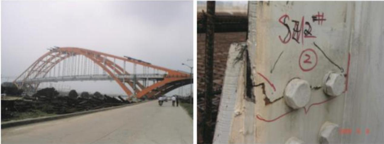
En agosto de 2006, un tifón atacó el Puente Dongping, un puente de arco de acero casi terminado en ese momento. La velocidad del viento era de unos 25 m / s. Más de 20 perchas oscilaron violentamente en torsión durante 20 horas y las 13 pendolas más largas resultaron dañadas
