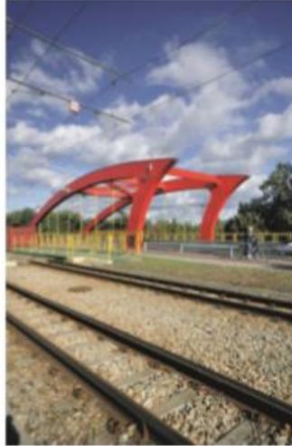
Se forman como dos pórticos de medio arco con sección en cajón, arriostrados por puntales y arriostramientos laterales superiores.
