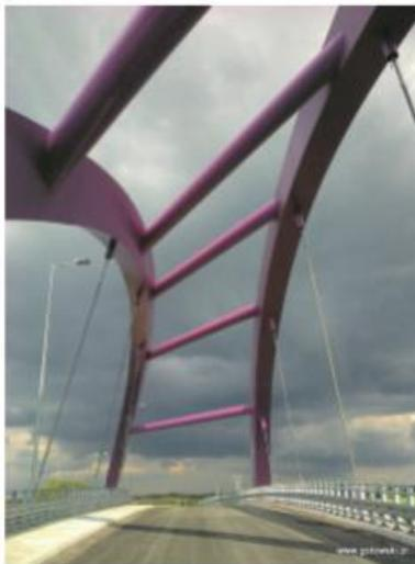
Estructura atípica con una luz de 80 m, formada por curvaturas asimétricas. El viaducto es curvo en planos horizontal y vertical y los tirantes tienen ángulo de inclinación variable.
