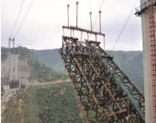
El método combinado significa la erección en voladizo utilizado para el anillo de arco en el arco y el método de construcción Melan utilizado para el anillo de arco en la corona del arco..
