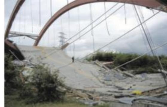
Cuando un autobús turístico y un camión sobrecargado pasaban por el puente, el tablero del primer tramo se derrumbó parcialmente como resultado de tirantes rotos.
