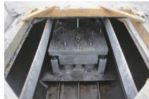
TMD: Amortiguador de masa sintonizada
