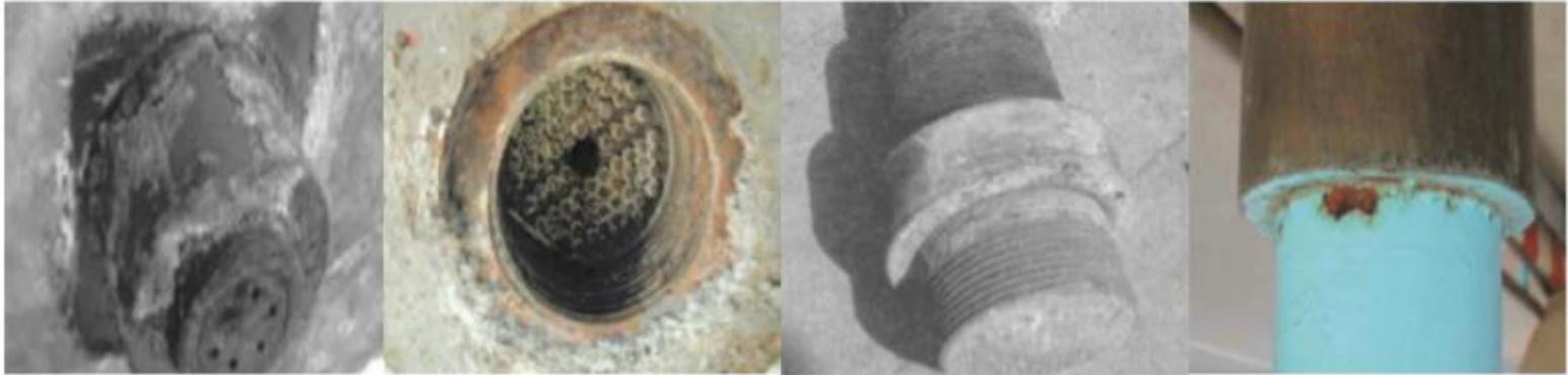
la corrosión del anclaje se puede dividir en corrosión externa y corrosión interna, que resultan de la protección ineficaz. Se muestra la corrosión encontrada en el anclaje de algunos tirantes
