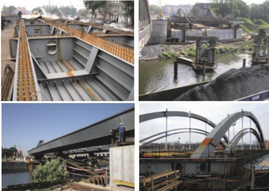
Los péndolas se tensaron una vez finalizado el lanzamiento, antes de retirar el soporte temporal. La última etapa de la construcción fue la fundición de la losa del tablero
