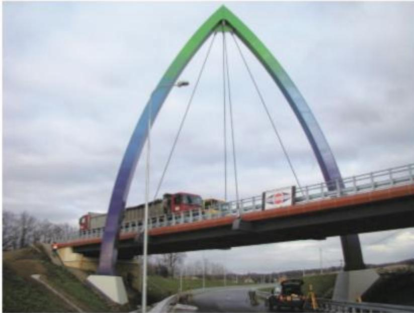
Un tramo compuesto de acero y hormigón con una longitud total de 61,50 m y un ancho de 8,80 m está suspendido de un pylon arqueado.
