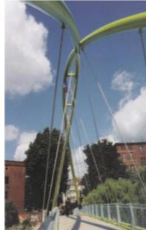
La parte principal de la pasarela es un arco atado de 48 m de largo. Consta de dos tubos de acero parabólico de gran altura con un diámetro de 0,51 m.
