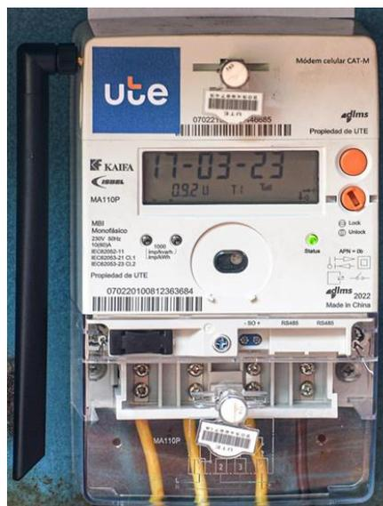
Figura. 3.4 Medidor inteligente de UTE
