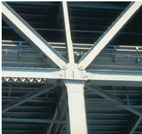
Figura 3.1 La foto muestra una conexión con junta de pasador sobre el acceso al puente.
