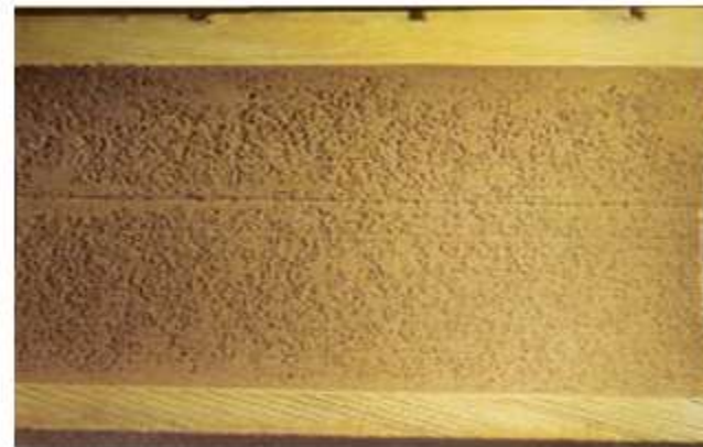
Corrosión ácida durante servicio
