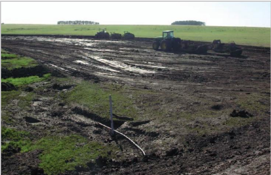
F. Aprovechamiento de cárcava para la colocación de la tubería.
