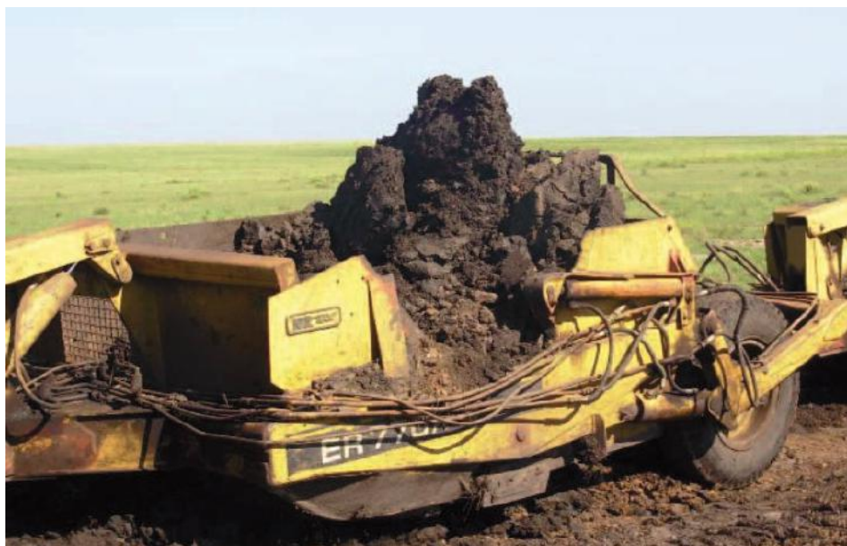
C. El uso del Tandem de dos traillas ahorra gasoil.
