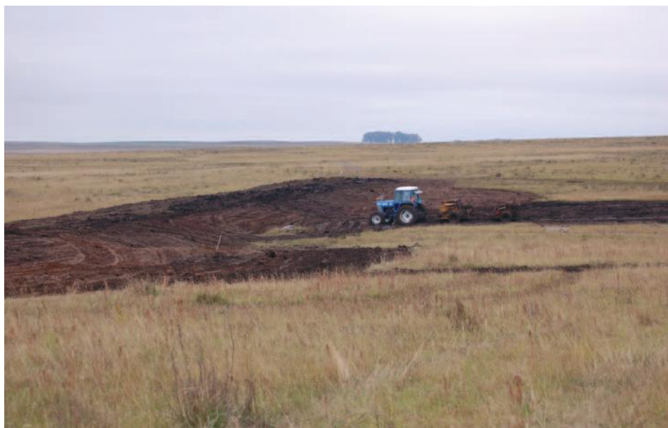
Tajamar demostrativo del campo de cría de CALTIECO, departamento de Paysandú, durante su construcción.
