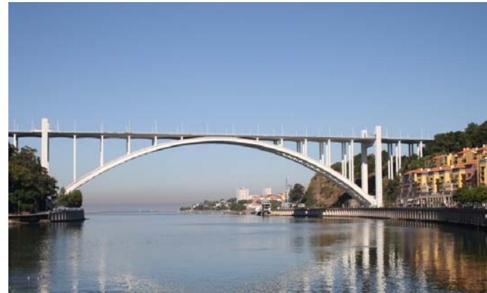
Puente de Arrábida en Oporto, Portugal.
