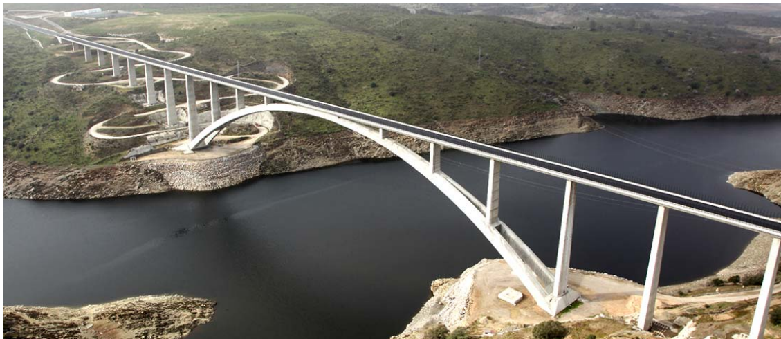
Puente sobre río Almonte, España.
