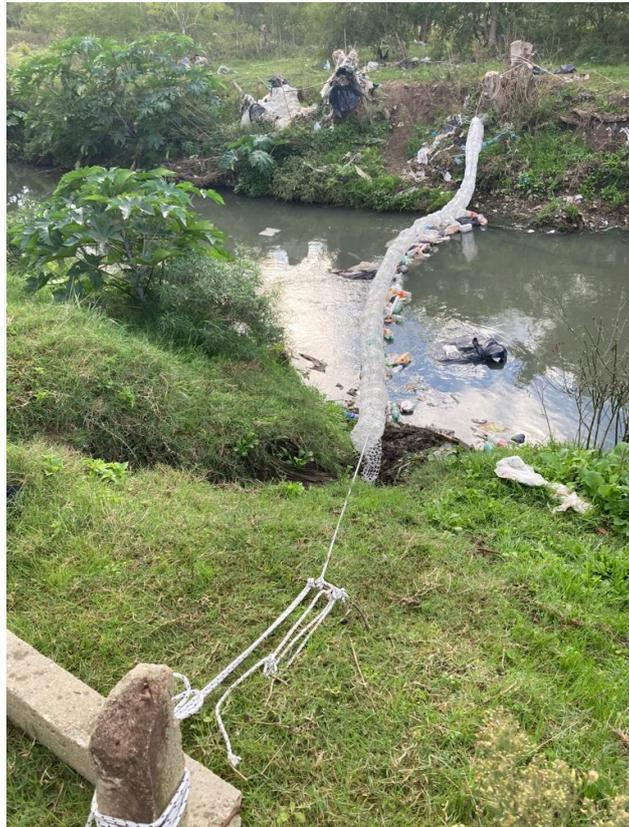
Figura 6-6. Biobarda instalada por equipo DIA-IMFIA en Arroyo Chacarita en 2023
