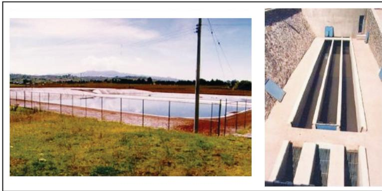
Figura 5.39. Cerco perimetral y sistema de rejás y desarenado.
