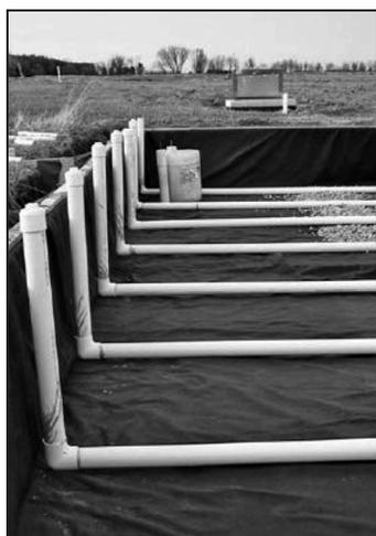
Figura 5.52. *Sistemas de tuberías de drenaje de humedales de FSSV antes de colocar el material de relleno. Tuberías perforadas en el fondo y no perforadas en la vertical.*
