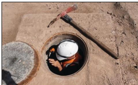
Figura 4.9. Registro: cámara de inspección.
