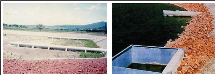
Figura 5.36. *Tubería de entrada sumergida. Tubería de entrada sobre el nivel de agua.*
