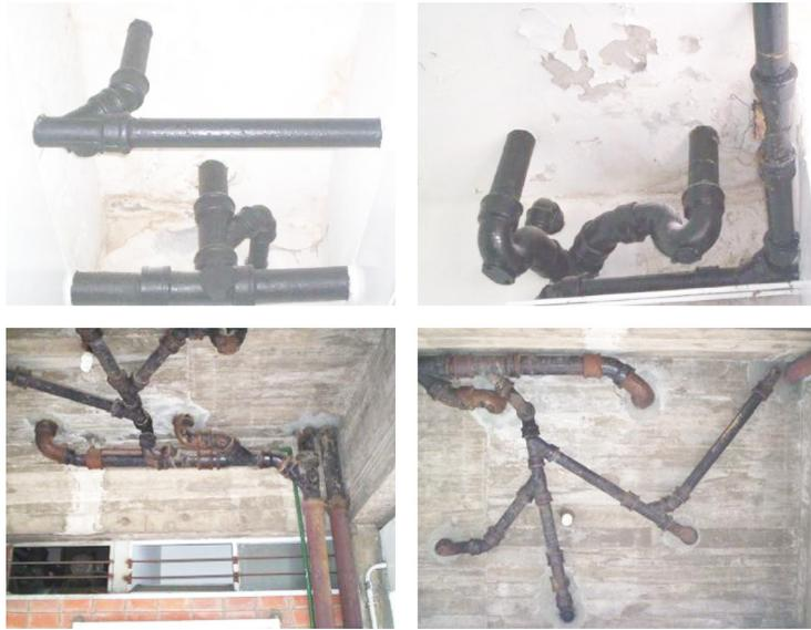
Figura 7.74. *Instalación suspendida (a).*
