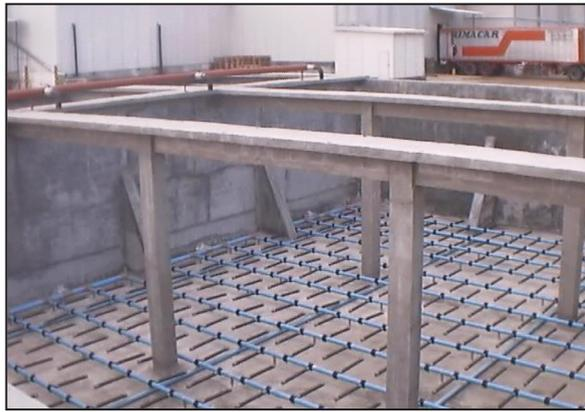
Figura 5.11. Esquema del sistema de lodos activados con aireación sumergida en el fondo.
