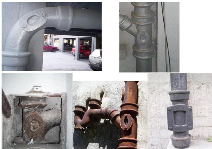
Figura 7.56. Puntos de inspección.
