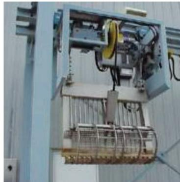
Figura 5.5. *Rejas de barra con limpieza mecanizada con grapo.*
