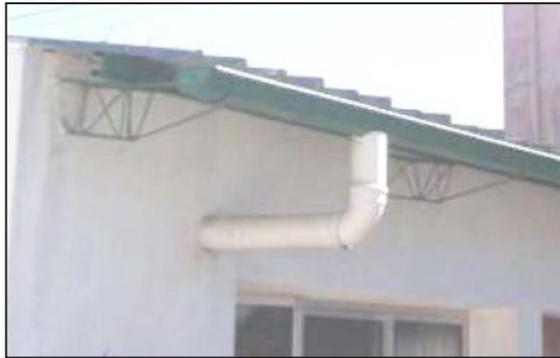
Figura 7.70. Canalón de desagüe de pluviales.
