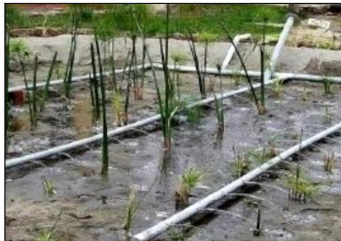
Figura 5.51. Sistema de entrada de un humedal de FSSV. Las tuberías fueron recubiertas posteriormente con grava. Tomada de González et al., 2016b.
