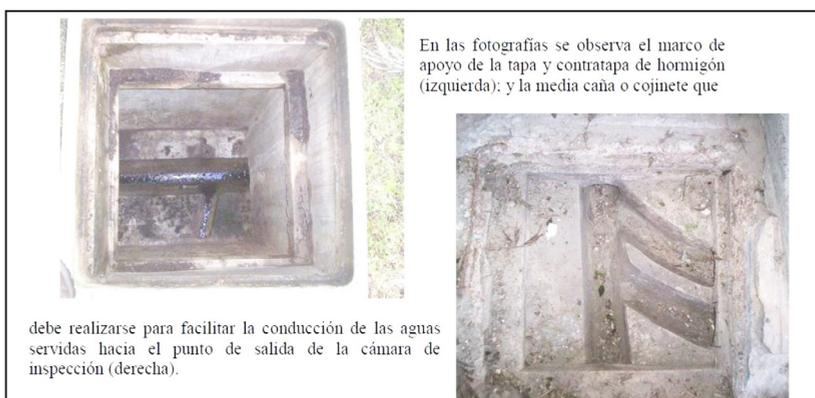
**Figura 7.54. Cámaras de inspección.**
