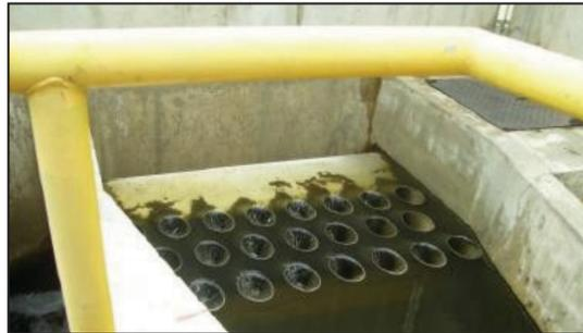
Figura 5.24. *Sistema de control de pelo de agua en desinfección con UV*
