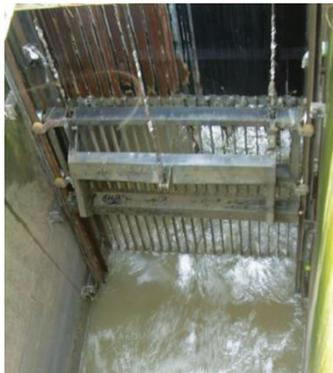
Figura 5.4. *Rejas de barra de limpieza mecánica con rastrillo.*
