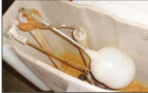
Figura 7.17. *Válvula de flotador.*
