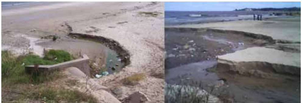
Figura 8. Vista de desagües pluviales en playa Pajas Blancas y playa Sta. Catalina. Fuente: Grupo MVD-Oeste – Salida de campo 17.05.2010 y Vecino Playa Sta. Catalina, 2010.
