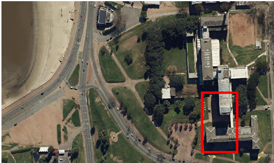
Figura 43 - Vista satelital de la Facultad de Ingeniería. (fuente: IDEUY).
