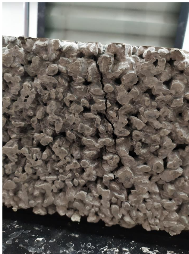
Figura 25 - Fisura de la viga en la zona de introducción de carga.
