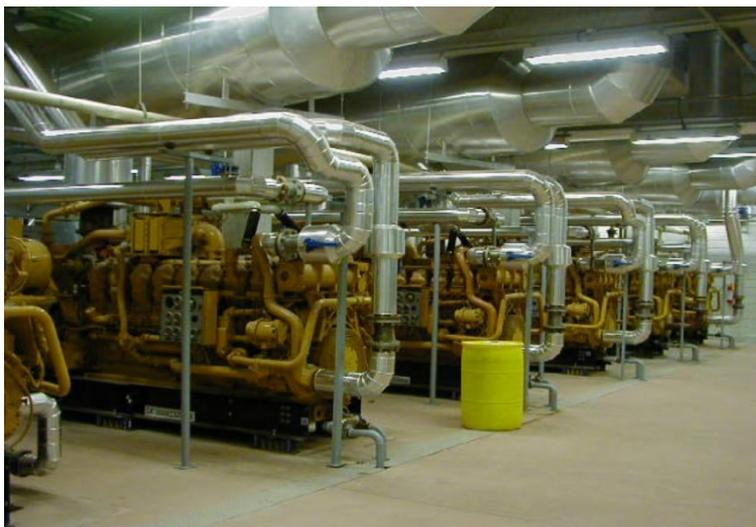
Figura 7-3: Conjunto de motores à biogás em um usina termoeletrica (fonte: Biogás Ambiental)
